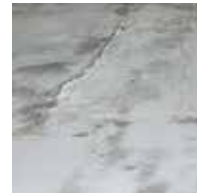
Unbehandelter Untergrund: Zementestrich/ Beton
