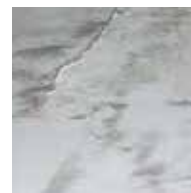
Grundierter, abgesandter Altestrich
