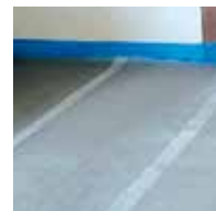
Geschädigter Untergrund: maxit floor Systemgewebe
