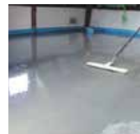
Rakeln der Spachtelmasse
