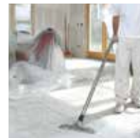
Untergrund schleifen und absaugen
