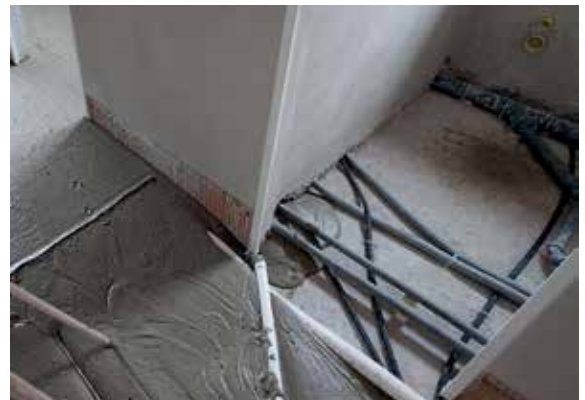
↑ Sichere Einbettung von Rohren, Leitungen und Kanälen.
