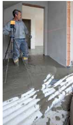
Höhenausgleich und Einbettung → von Versorgungsleitungen.
