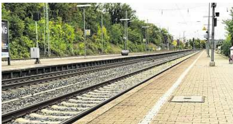
Der barrierefreie Ausbau der Bahnsteige am Kitzinger Bahnhof wird noch ein Weilchen auf sich warten lassen.
